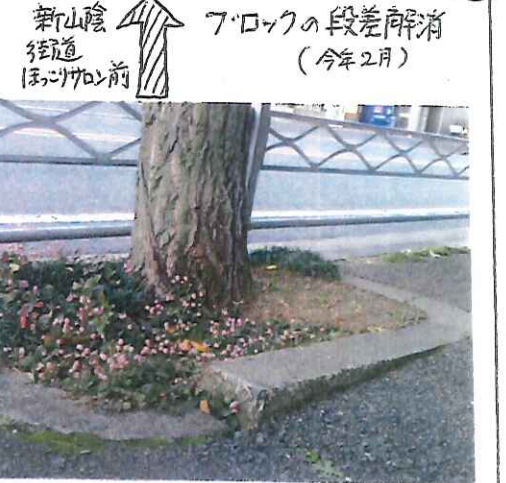
新山陰 街道 ぼんちヤン前 フロックの段差解消 (今年2月) 歩道の街路樹のまわりのフロックが(昨秋)浮きあがり、「つまずきそくに」の声
