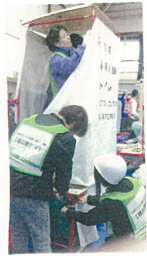
仮設トイレの設置も(12/9 西京総合防災訓練)
